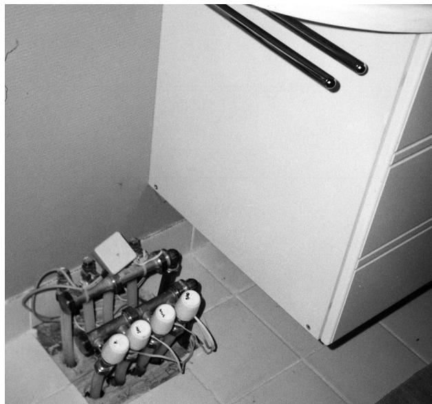
Fordelerrørsinstallation til gulvvarmen placeret i baderum uden for vådzone.
